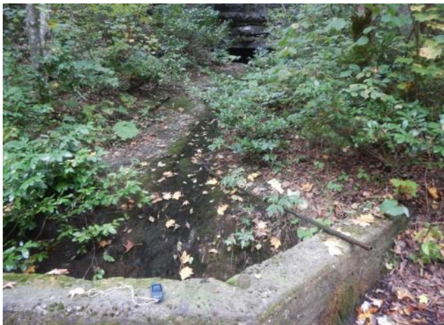
RAW 022, captage et porche d'entrée de l'émergence
