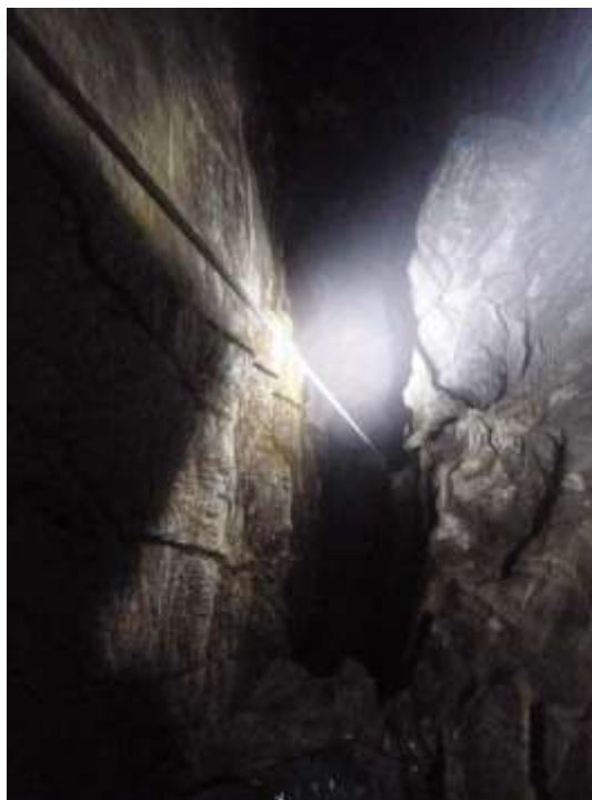
MUK 003, puits intermédiaire
