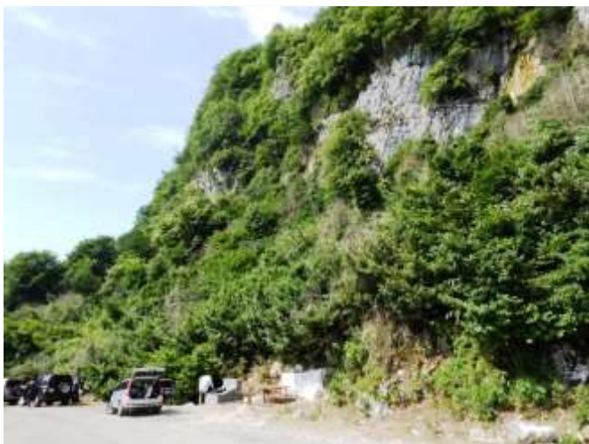
Arrivée du captage
