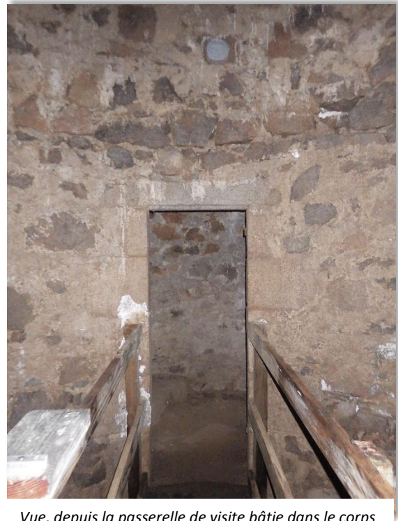
Vue, depuis la passerelle de visite bâtie dans le corps de la glacière, de l'arrivée de l'escalier
