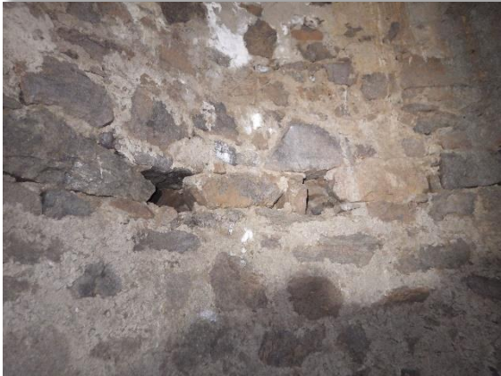
Maçonnerie du corps de la glacière et empochements
