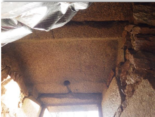
La pierre d'évier en réemploi derrière le linteau de l'entrée (conduite d'eau au premier plan)
