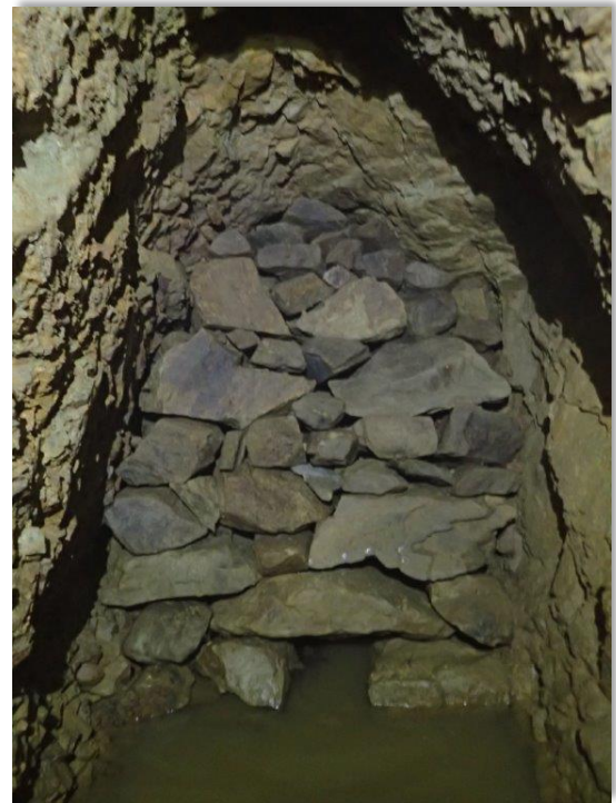
L'aqueduc et la murette d'écoulement
