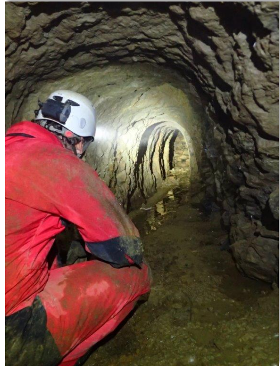
L'aqueduc et la murette d'écoulement
